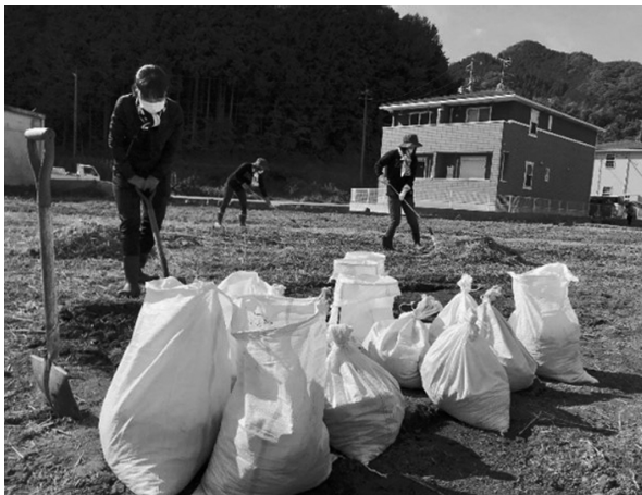
図11. 田んぼに流入した汚泥を除去する作業
