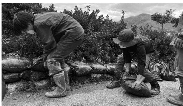
図6. 土砂や洪水を防ぐ止水用土嚢を積み上げる作業
