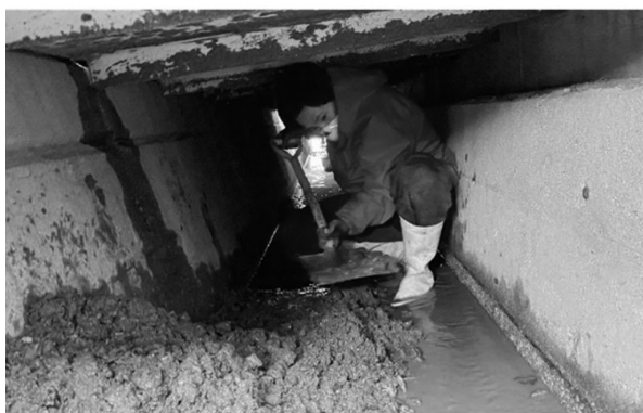
図7. 溝蓋下に堆積した土砂を除去する作業
