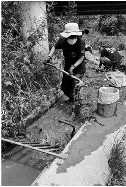
図10. 用水組合依頼の水路の土砂撤去作業
