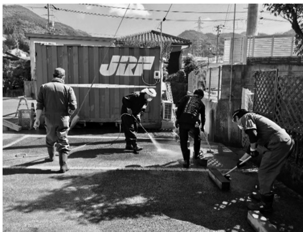
図3. 保育所前の駐車場に堆積した汚砂を除去する作業
