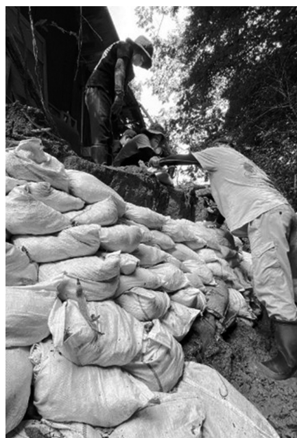
図9. 豪雨で侵食された庭の応急処置
