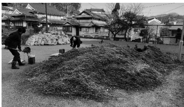
図5. 公園に積み上げられた汚泥の山を除去する作業
